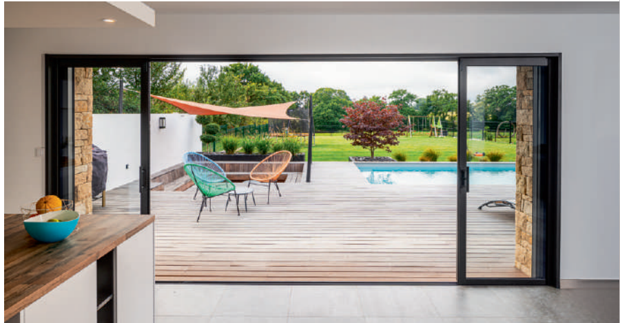
Baie à galandage 4 vantaux (4,60 m de large) : 100 % d'ouverture
