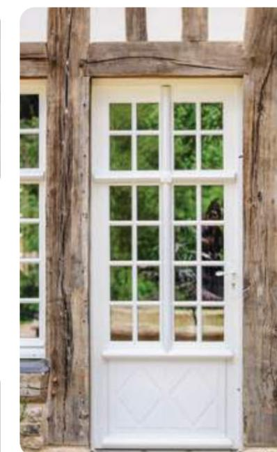
Plus d'une cinquantaine menuiseries (portes et fenêtres) ont été réalisées sur-mesure pour ce projet. Afin de retranscrire l'esprit de l'époque, **les fenêtres sont composées de petits bois reproduisant les traditionnels petits carreaux normands**
