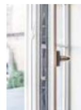
**Fermeture par crémone encastrée :** intégrée dans un des vantaux, la crémone est invisible et verrouille la fenêtre par action de la poignée.
