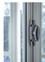
**Fermeture mouton et gueule de loup :** hérité des menuiseries d'autrefois, ce système de fermeture est permis grâce à l'emboîtement d'un des vantaux dans l'autre. On actionne une crémone en applique ou une espagnolette pour verrouiller la fenêtre. La fenêtre à mouton et gueule de loup d'Atulam a été conçue pour offrir les meilleures performances.
