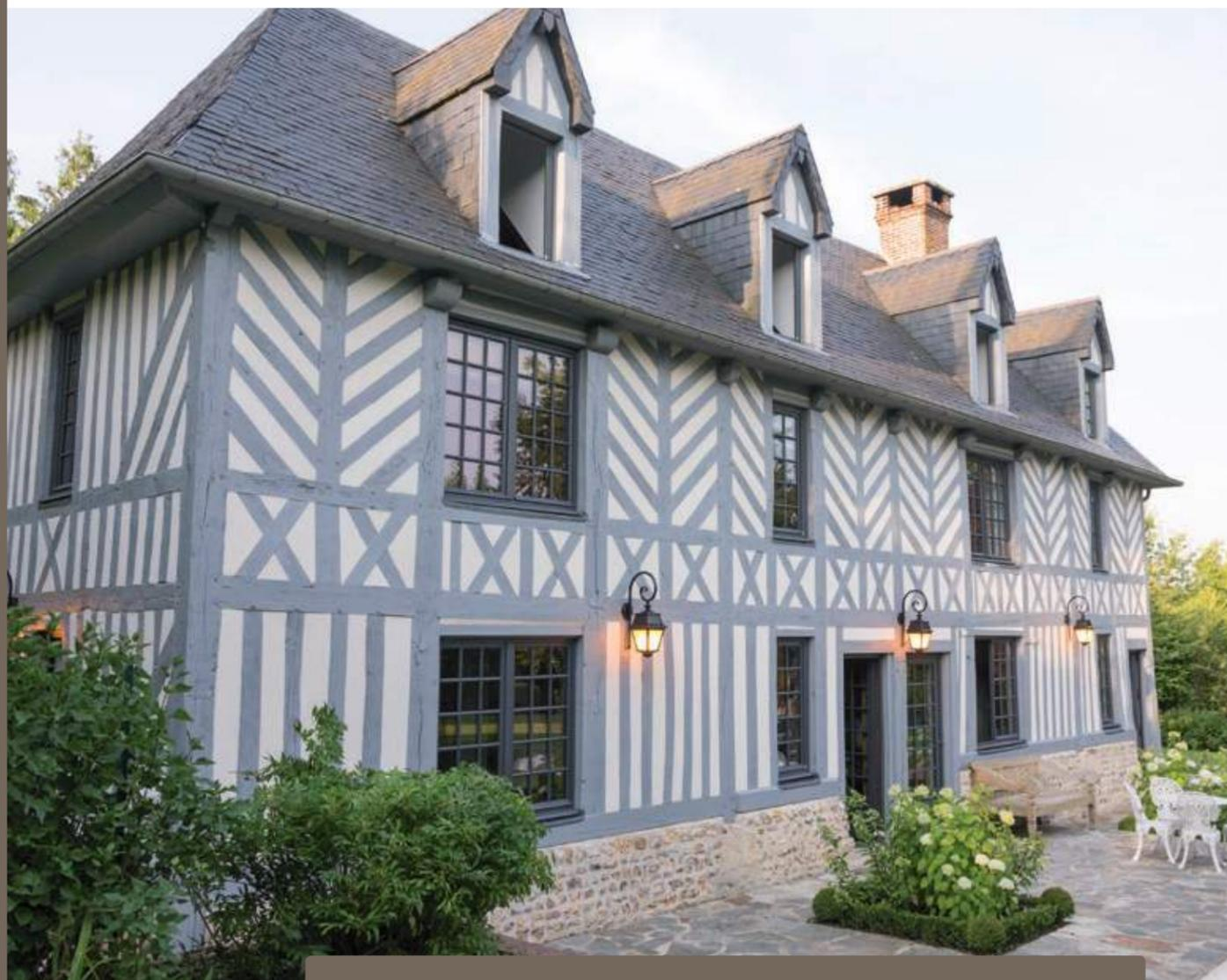
La rénovation de ce manoir situé dans le Pays d'Auge a nécessité le remplacement d'une trentaine de menuiseries en dépose totale. Un exercice périlleux, puisqu'il a fallu intégrer les portes et fenêtres dans l'esthétique de la façade à colombage repeinte en gris.
