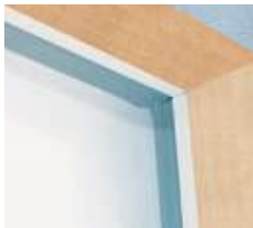
Joint d'étanchéité en périphérie
