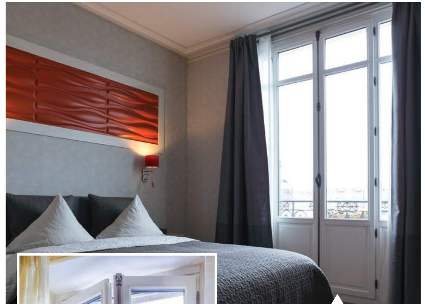
Porte fenêtre Estilou Finition peinture blanche RAL 9016 Parceloses et petits bois à doucine Crémone véritable et fiches turlupet vieil argent
